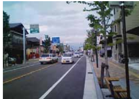
歩道整備施工後
