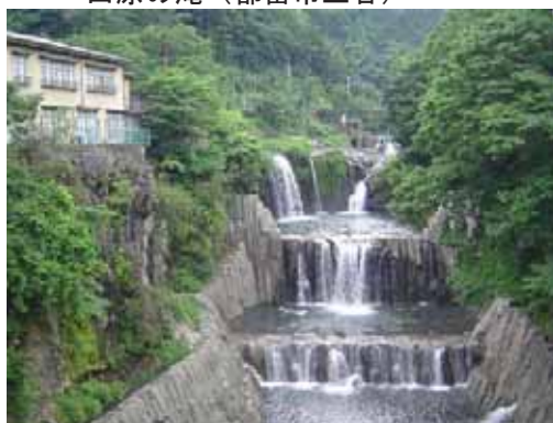
景観に配慮した相模川砂防施設 田原の滝 (都留市上谷)
