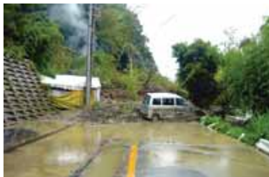
(国道52号(身延町))
