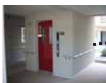
エレベータの設置
