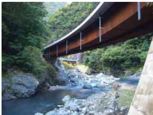
耐候性鋼材を使用した橋梁 南アルプス公園線 新琴路橋
