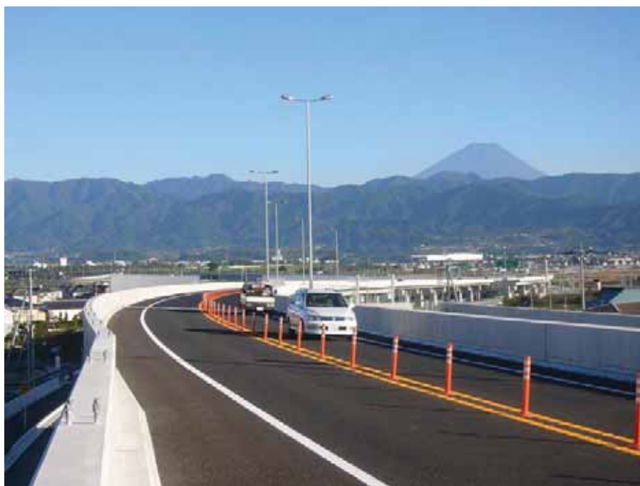
新山梨環状道路南部区間
