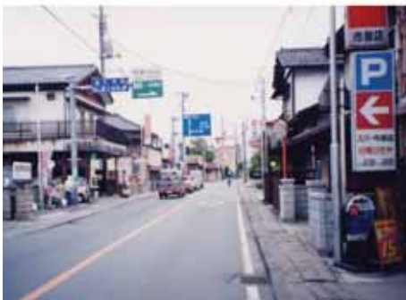
国道 4 1 1 号 笛吹市 市部付近 歩道整備施工前
