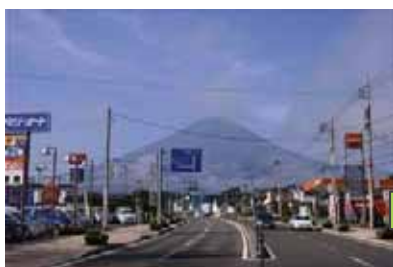
無電柱化 富士河口湖富士線 富士河口湖町船津地内
