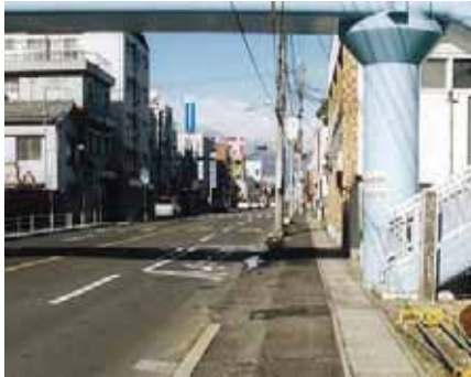
甲府韮崎線 甲府市新紺屋地内 歩道フラット化施工前
