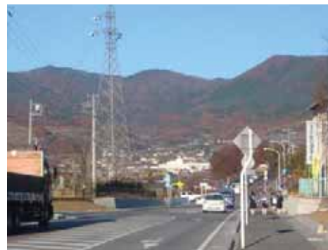
歩道整備施工後
