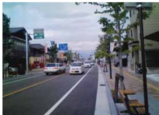
歩道整備施工後
