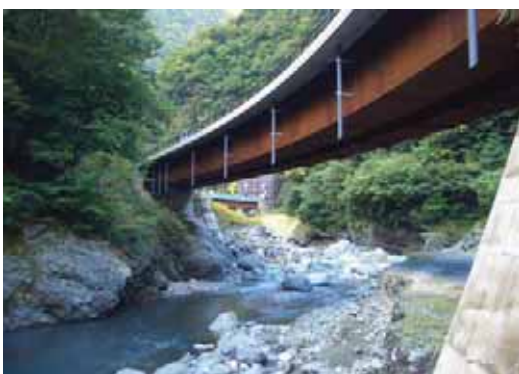
耐候性鋼材を使用した橋梁 南アルプス公園線 新琴路橋
