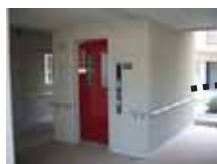
エレベータの設置
