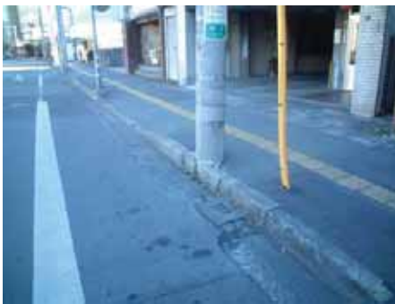
歩道フラット化施工前
