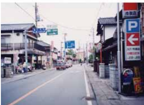
歩道整備施工前
