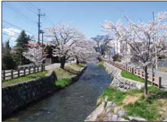
一級河川西川 笛吹市石和町 整備状況
