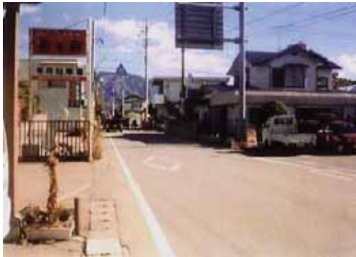
歩道整備施工前
