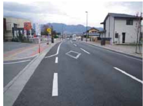
歩道整備施工後
