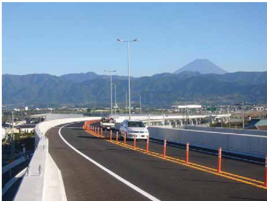
新山梨環状道路南部区間
