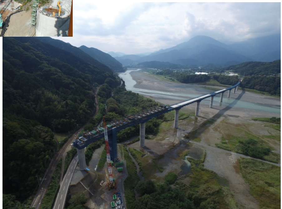
「中部横断自動車道 富士川橋」 平成27年9月29日撮影
