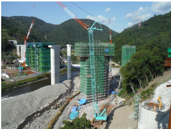
「中部横断自動車道 身延1C」 平成27年10月6日撮影
