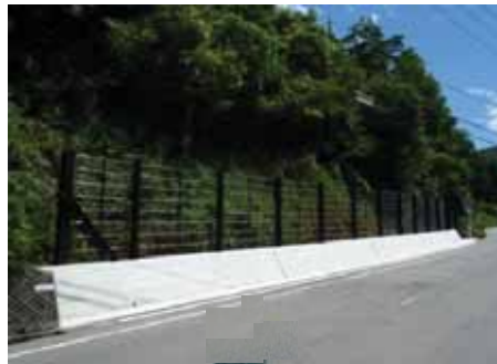
落石防護柵工
