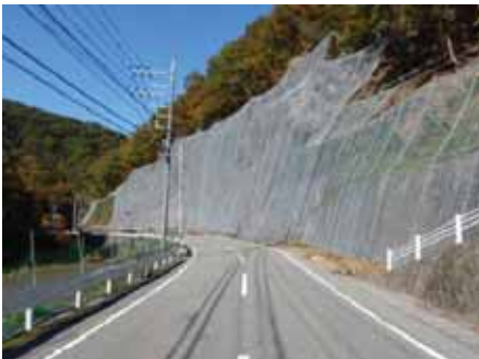
落石防護網工
