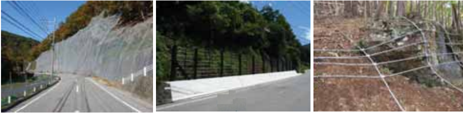
落石防護網工
