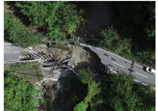
(主)南アルプス公園線(早川町湯島)
