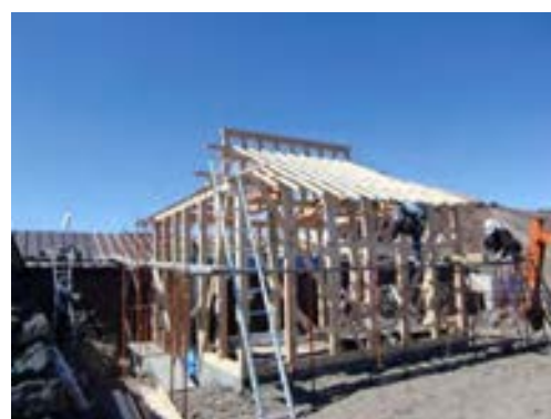
建替え中の奥宮本殿
