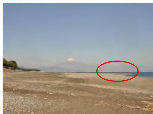
<L型突堤施工後20年>
