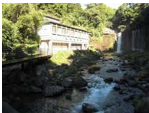
滝壺にあった人工構造物
