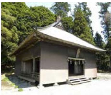
村山浅間神社・大日堂修理前
