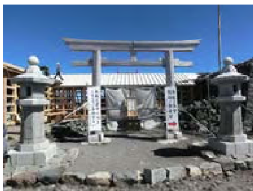
改修中の奥宮
