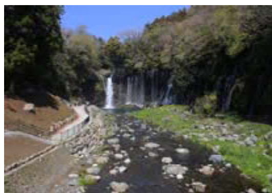
人工構造物撤去・修景整備後
