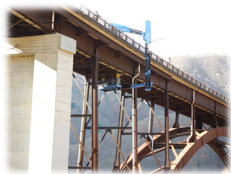
国道 140 号 鶏冠山大橋
