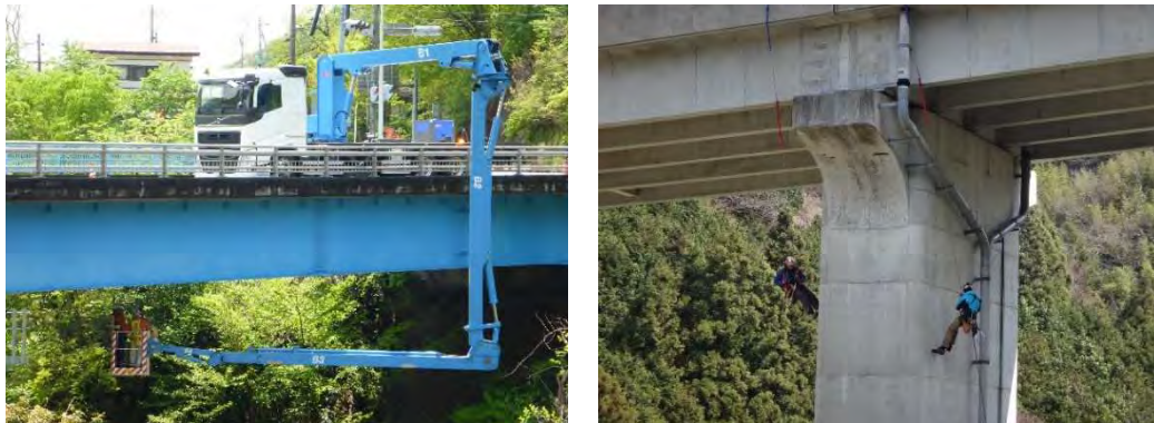
写真 2-8 従来の点検方法（右：橋梁点検車、左：ロープアクセス）
