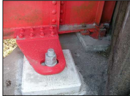
写真 2-4 変位制限装置(ピン形式)
