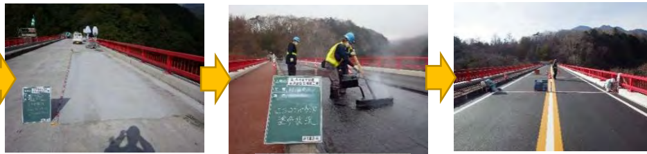
コンクリート打設
