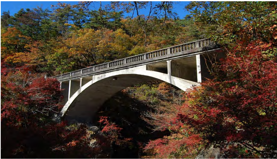
主要地方道 甲府昇仙峡線 長潭橋
