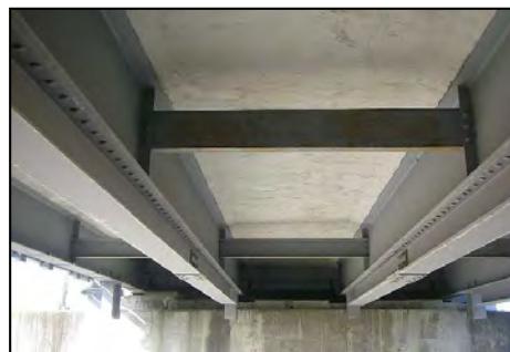
写真 2-7 主桁断面増加
