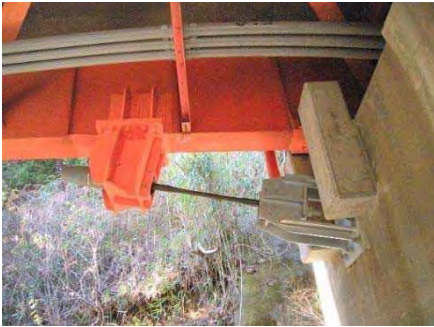
写真 2-3 落橋防止装置(連結ケーブル形式)
