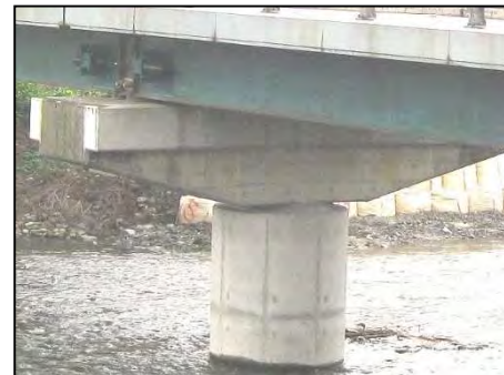
写真 2-6 縁端拡幅・橋脚補強 (RC 縁端拡幅・橋脚 RC 巻立て)
