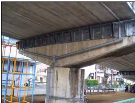
写真 2-5 縁端拡幅・橋脚補強 (鋼製ブラケット・橋脚 RC 巻立て)
