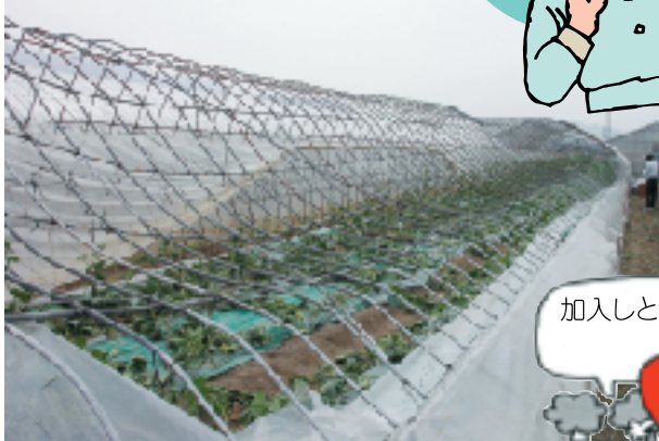
●突風により倒壊したハウス
