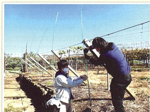
設置作業の様子
