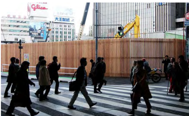
写真 4.5.42 間伐材による仮囲い
