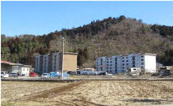
写真 4.5.38 背景の山岳に調和する色彩の選択 自然界の基調色（10YR）の色相による塗装改修後の団地（写真左）と改修前の団地（写真右）【景観アドバイザー活用事例】 （都留市・県営住宅熊井戸団地）
