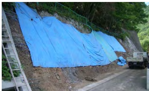
写真 4.5.43 仮囲い（周囲から突出した色彩）
