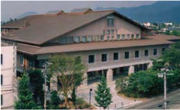
写真 4.5.36 エイジングする屋根材の採用 経年変化により味わい深い緑青になる銅版で、屋根を葺いた例
