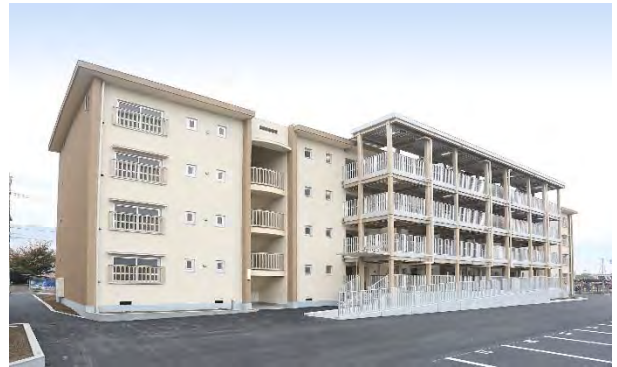
写真 4.5.39 明度差による塗分け 同じ色相の明度の差により塗り分けた例。ブラウン 10YR 6/1.5、ベージュ 10YR 8/1.5【景観アドバイザー活用事例】 （市川三郷町・県営住宅三珠団地）
