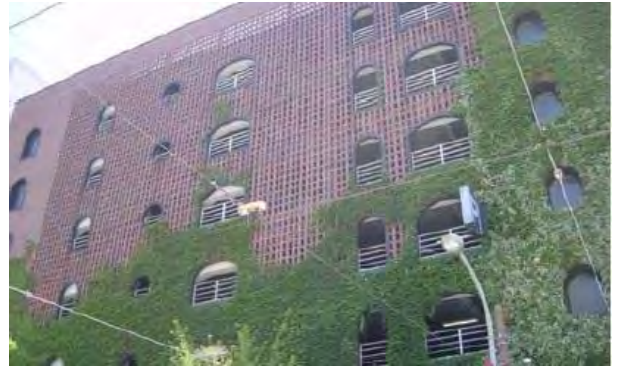
写真 4.5.37 植栽（ツタ類）の援用 立体駐車場の外壁を通風性の良いものとし、かつツタ類が壁面を徐々に覆い、味わいがでていく
