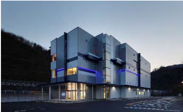
写真 4.5.40 照明による強調 リニアをイメージした建物外観を引き立てる光色の採用。
