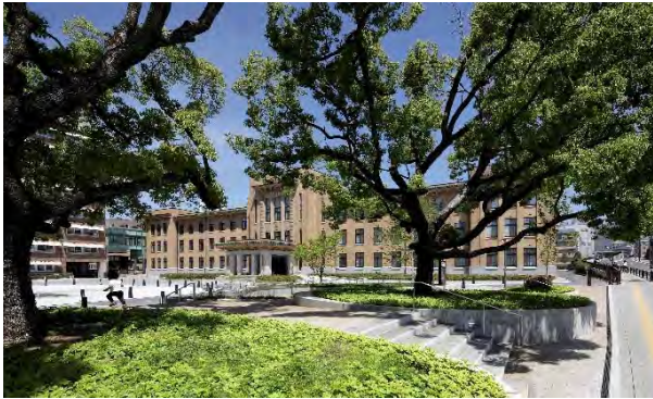
写真 4.5.32 オープンスペースへの緑化 オープンスペースに高木のシンボルツリーを配置することで休憩スペースに日陰をつくる効果が生れている。 写真提供：グラスアイ/海老原一己（甲府市・山梨県庁）
