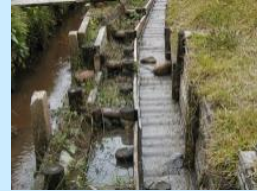
■ 水田魚道の設置
