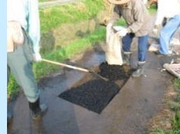
■ 農道舗装の補修
