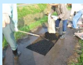
■ 農道舗装の補修
