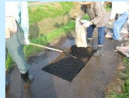
■ 農道舗装の補修
