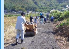
■ 未舗装農道の舗装
