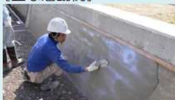
老朽化した水路壁のコーティング
