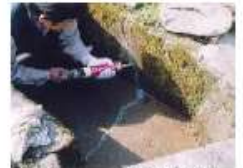
水路のひび割れ補修
