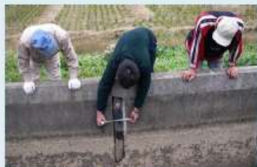
施設の機能診断
