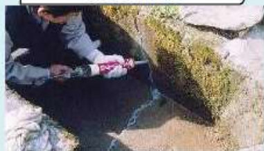
水路のひび割れ補修
