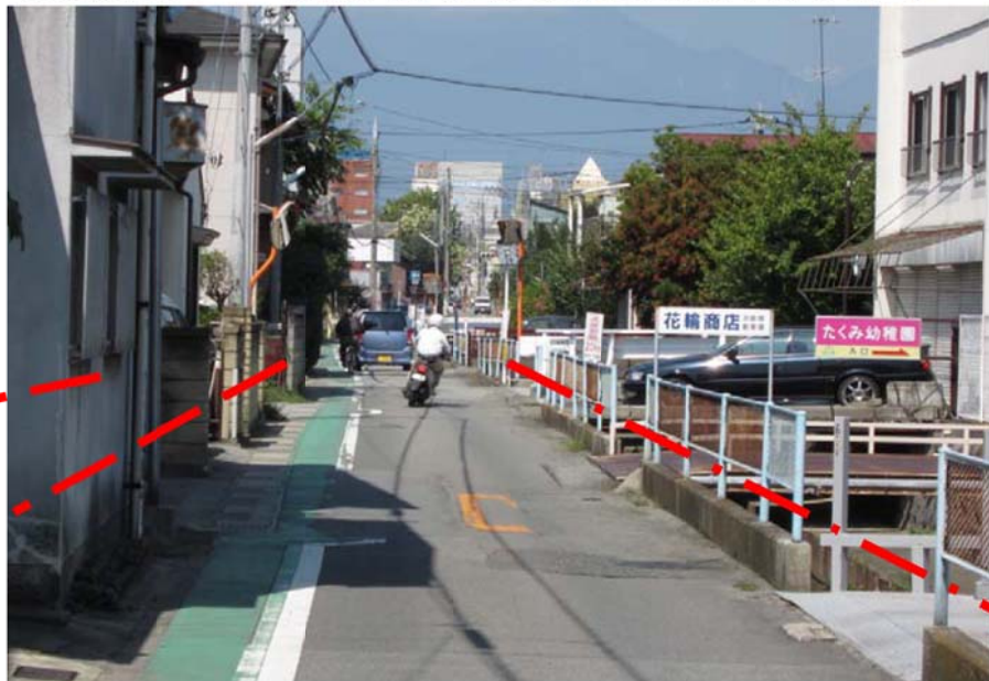
⑤城東工区 幅員が狭い地域内道路に濁川が平行している
