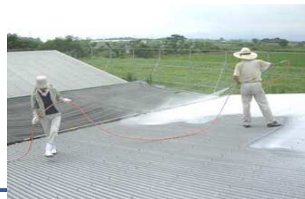
石灰の吹きつけ
