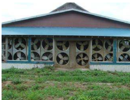
牛舎壁面の換気扇
