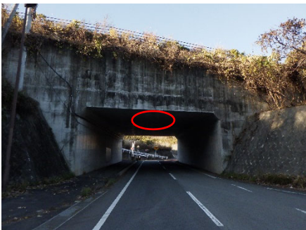
(4-1) 国道 137 号笛吹 3 号カルバート：国道 137 号
