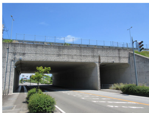
南アルプス甲斐線 新環状南部 4 号カルバート
