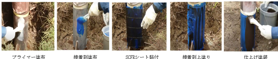
写真6.2 損傷補修技術
