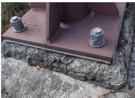
(3) 照明柱基礎コンクリート (健全性Ⅲ)
