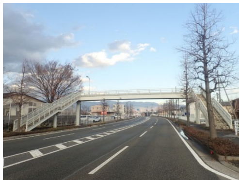
甲府南アルプス線 南っ子横断歩道橋
