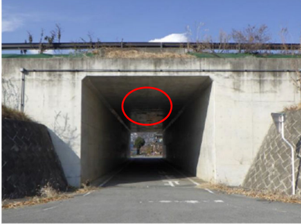
(1-1) 西関東 12 号カルバート：西関東連絡道路
