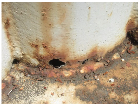
(1) 照明柱地際部 (健全性Ⅲ)
