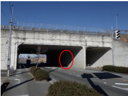
(3-1) 新環状南部 4 号カルバート：新山梨環状道路
