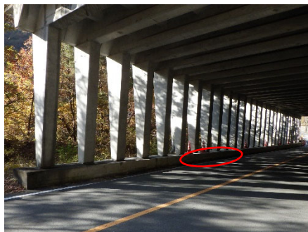
(4-1) 滝口第2洞門：国道411号
