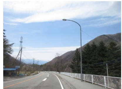
道路照明（逆L柱）
