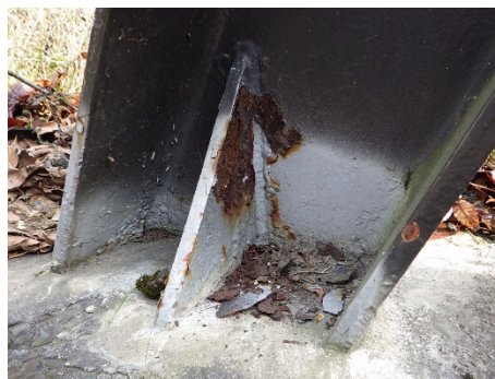
(2) 門型柱地際部 (健全性Ⅱ)
