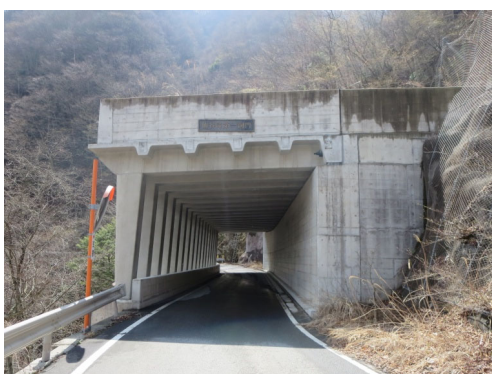
南アルプス公園線 仙谷滝第一洞門
