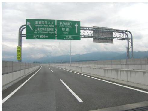
韮崎南アルプス中央線 門型標識
