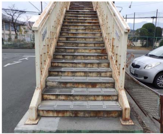
(2)田富歩道橋 (未設置例)
