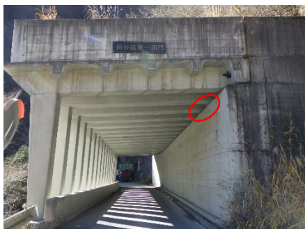
(2-1) 仙谷滝第1洞門：南アルプス公園線
