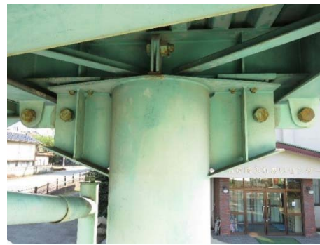
(4) 八代南歩道橋
