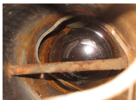
(4) 照明柱内部 (健全性Ⅲ)
