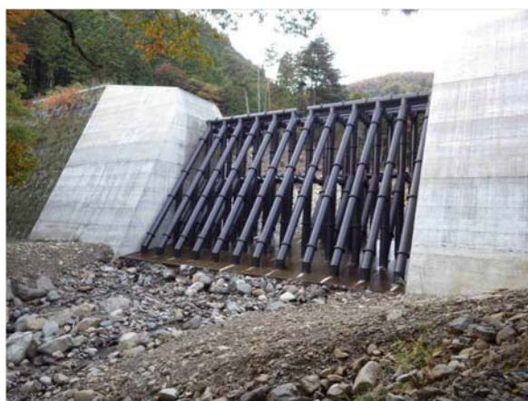
写真 1.4.3 相模川水系 籠子川・滝子川砂防堰堤（透過型砂防堰堤、H26.3 完成）
