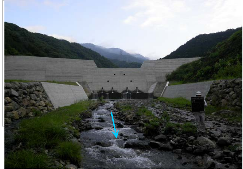
②堰堤工完成状況
