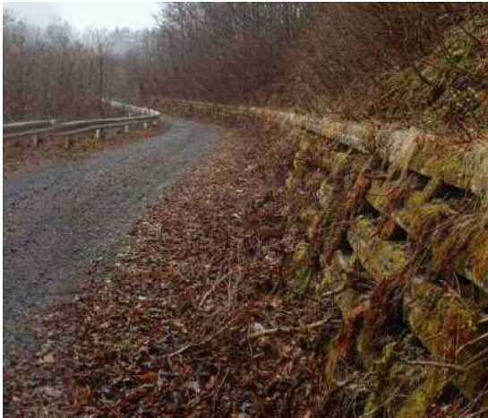
① 完成区間の間伐材利用状況（木製土留工）
