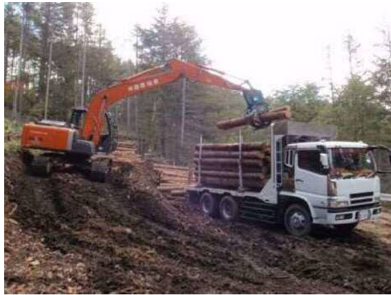
② 沿線の木材搬出状況
