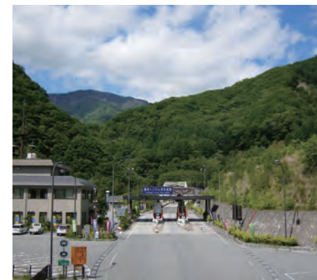
国道140号雁坂トンネル有料道路 料金所
