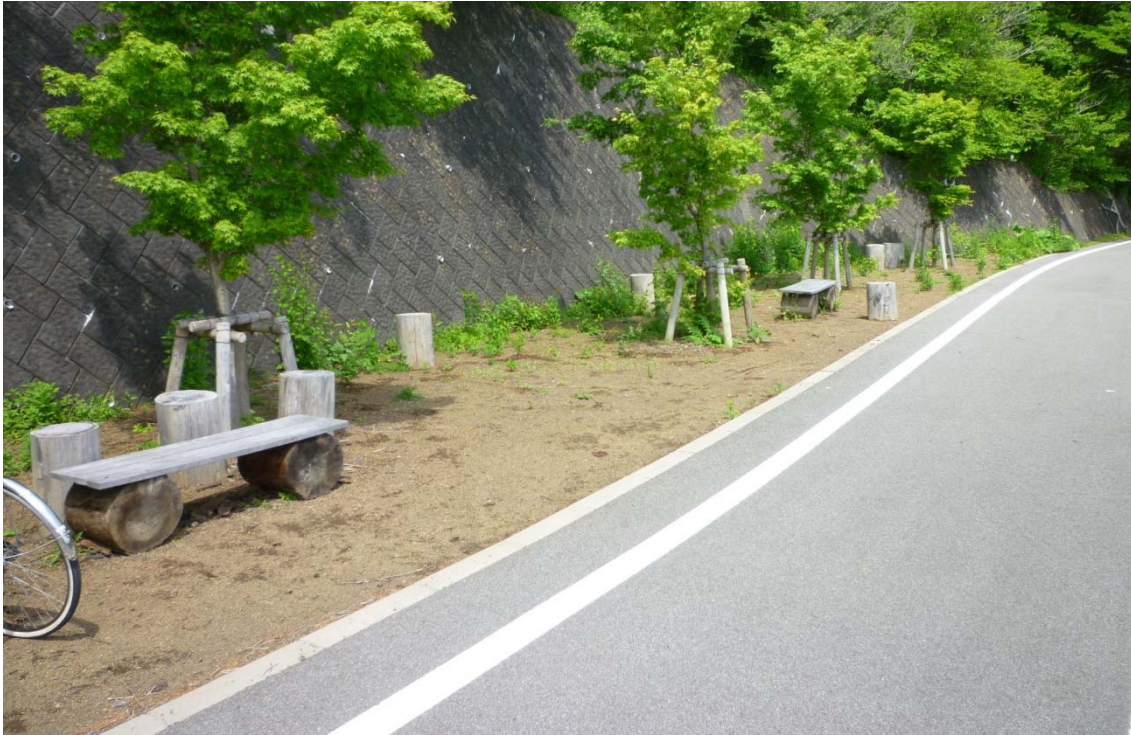
図 20 山中湖湖畔に設置されたベンチ
