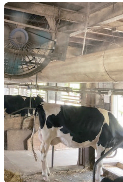
換気装置に細霧を組み合わせた牛舎内温度低減の取り組み
