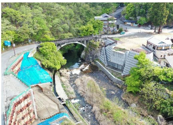
長潭橋の下流に新たな橋の建設を推進。現在、新しい橋の橋台を建設しています。
