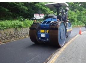
経年劣化で傷んだ舗装の舗装修繕工事の様子。管内にある路線の舗装状況を把握し計画的に修繕を実施しています。
