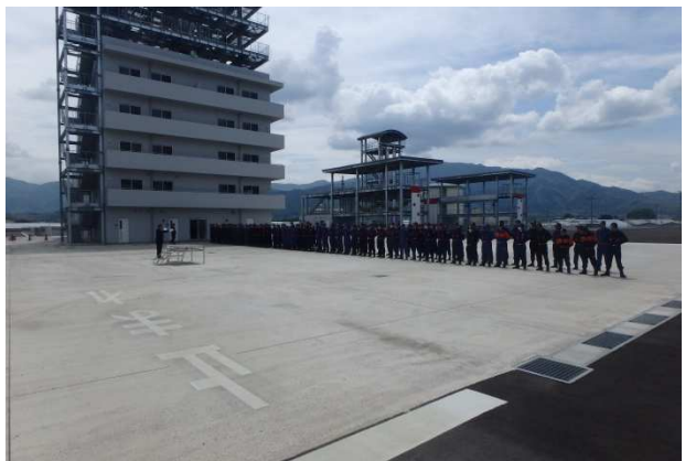
全天候型放水訓練施設
