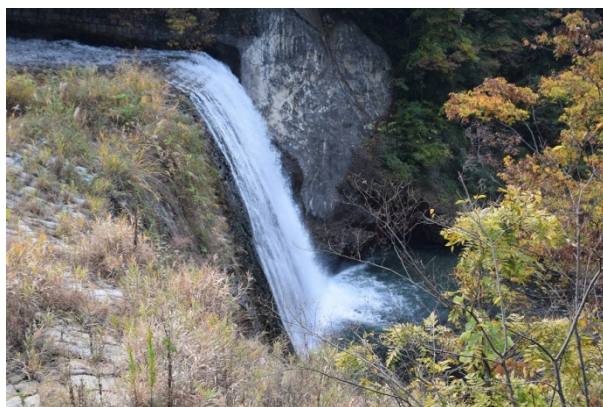
大正時代に完成した近代土木遺産 流れ落ちる滝は祇園の滝として親しまれている。 (甲州市 勝沼堰堤)
