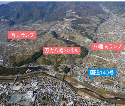
西関東連絡道路(甲府山梨道路)の万カランプ～八幡南ランプ間は平成26年12月に開通
