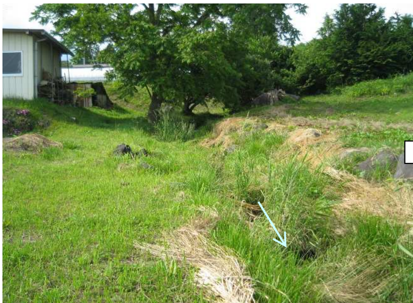
改修前 河川断面不足箇所
