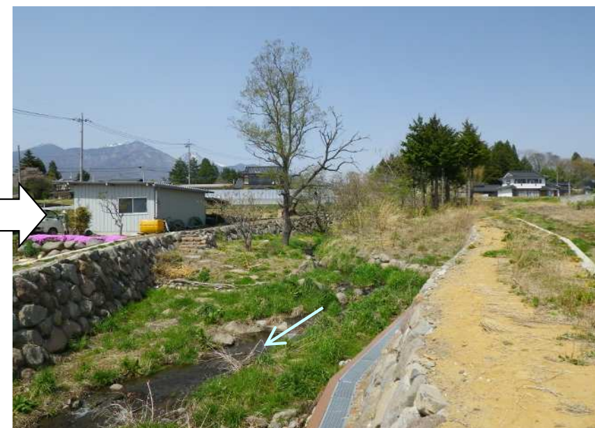
改修後 河川断面不足箇所
