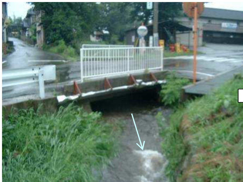
改修前 市道橋梁部
