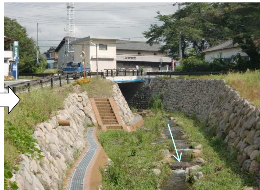
改修後 市道橋梁部
