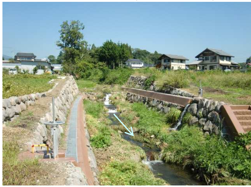
天神橋より下流 完成後(平成25年9月撮影)
