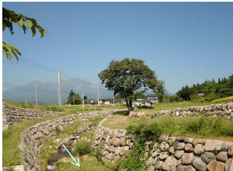
完成後(平成25年9月撮影)
