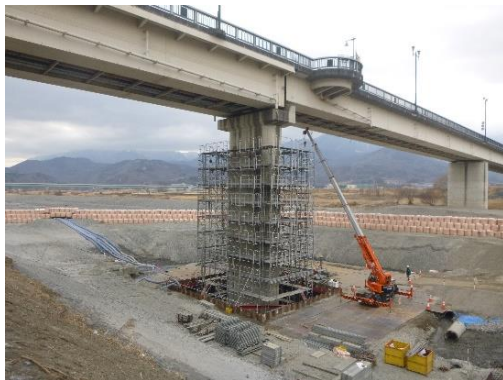
鉄筋コンクリート巻立て工法 施工状況
