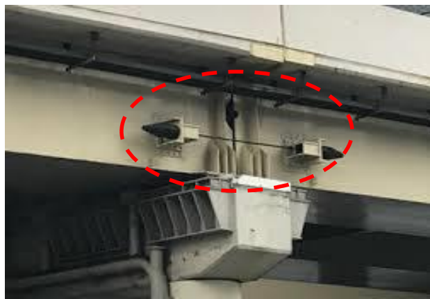
橋桁と橋桁を連結する「PCケーブル」
