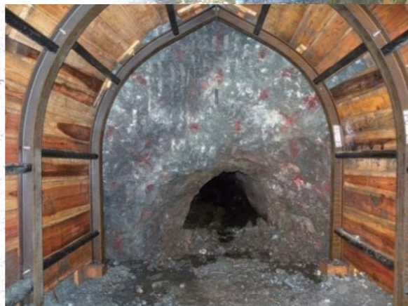
施工中のトンネル内部
