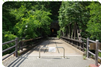
中央線の廃トンネルを活用した大日影トンネル遊歩道
