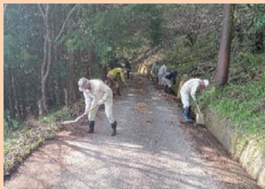
農道の清掃作業
