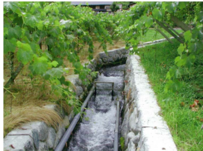
完成後 自然石を利用し、環境に配慮した水路整備により、流下能力が高まり、畑が水食されることが無くなった。
