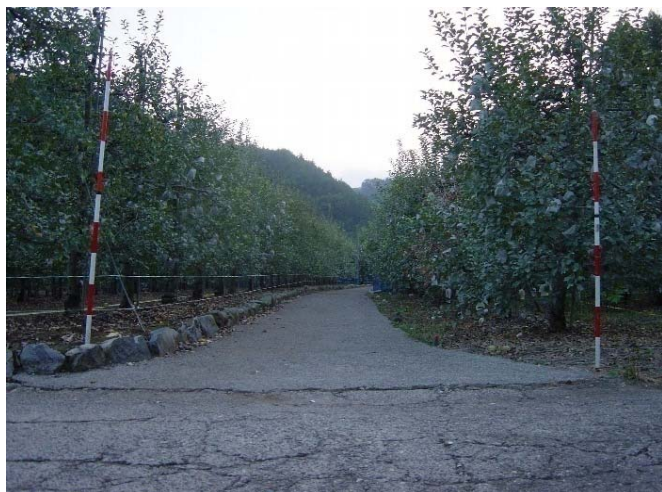
着工前 農道の幅員が狭く、通作などに支障を来していた。
