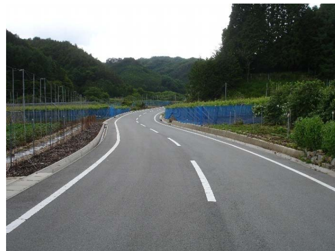
完成後 農道の整備により、農耕車が容易にすれ違えるなど、安全性と農作業の利便性が向上された。
