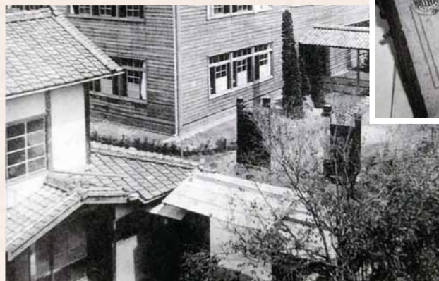
1906(明治39)年、甲府市湯田(旧・湯田町)に新校舎を建設。 穴山村伊藤家の住宅や蔵を解体して資材とした
