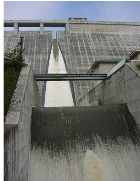
平成23年9月 台風15号による出水状況
