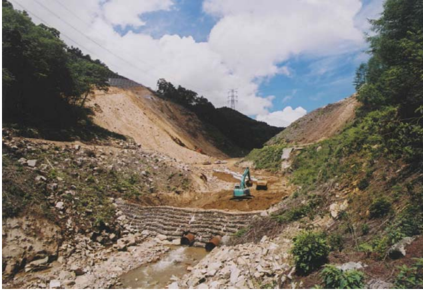
着工前(下流面)
