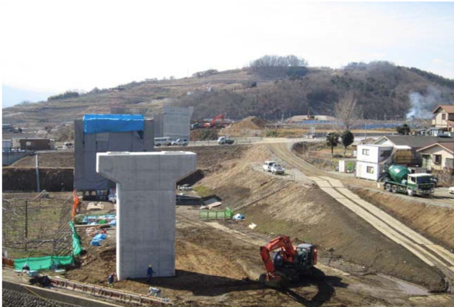
③八幡バイパス交差部施工状況
