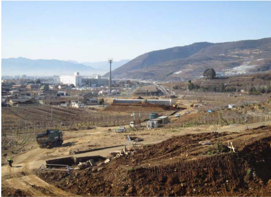
① I期終点～万力地区施工状況
