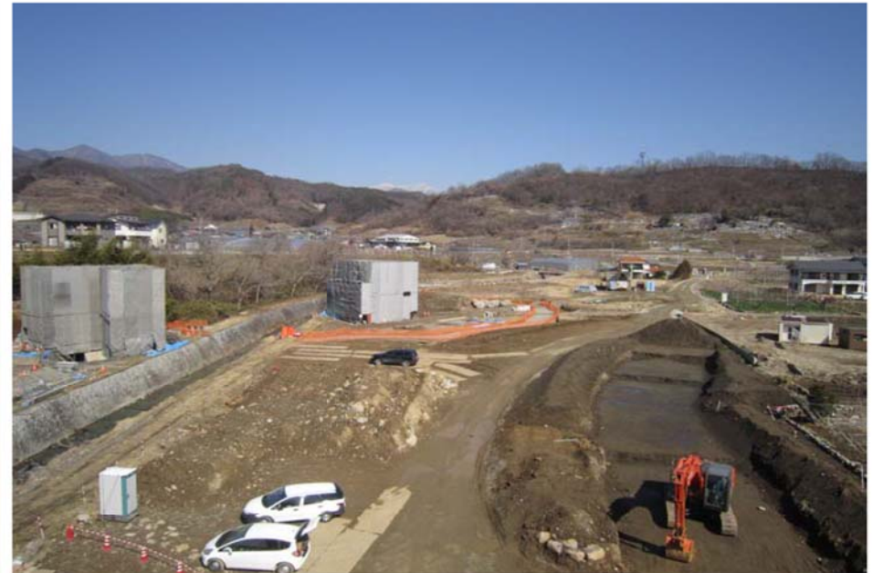
④北地区～荒神山方面施工状況
