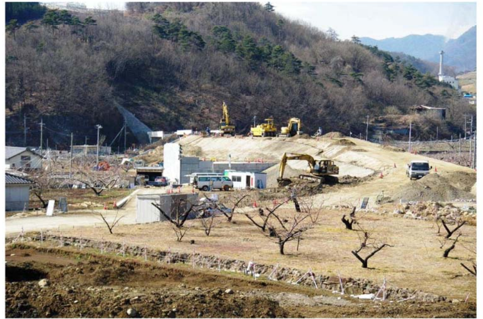
②(仮)万カトンネル八幡側～南地区施工状況
