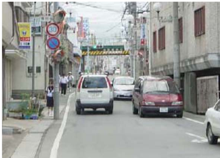
⑦旧道 市街地(JR交差付近) [事業着手前]
