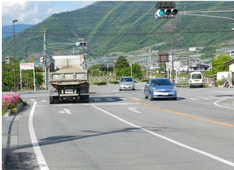
⑤熊野橋西交差点付近(市道との交差点)
