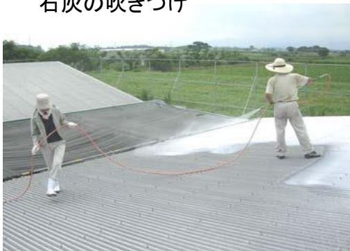
石灰の吹きつけ
