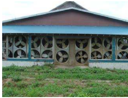
牛舎壁面の換気扇
