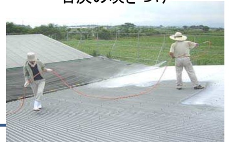
石灰の吹きつけ
