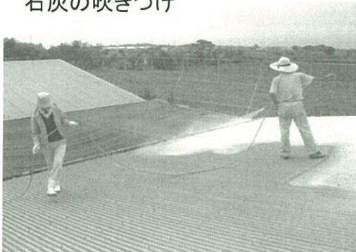
石灰の吹きつけ
