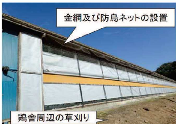
防鳥ネットの設置
