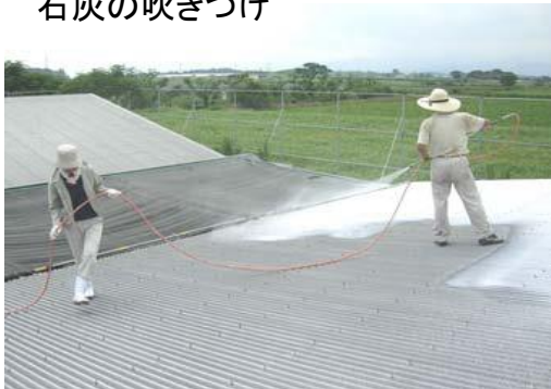
石灰の吹きつけ
