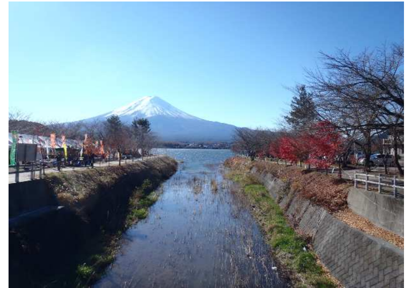
西川上流から架橋位置を望む
