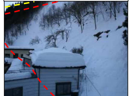
斜面状況写真(遠景)
