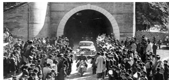
新笹子トンネル開通
