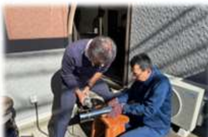
電動グラインダーでの切断作業。頼もしい！
