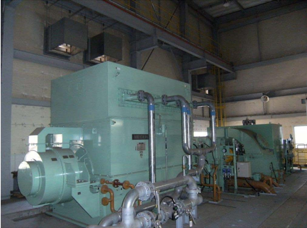
写真 10-3-1(3) 防音ボックス (発電タービン部)
