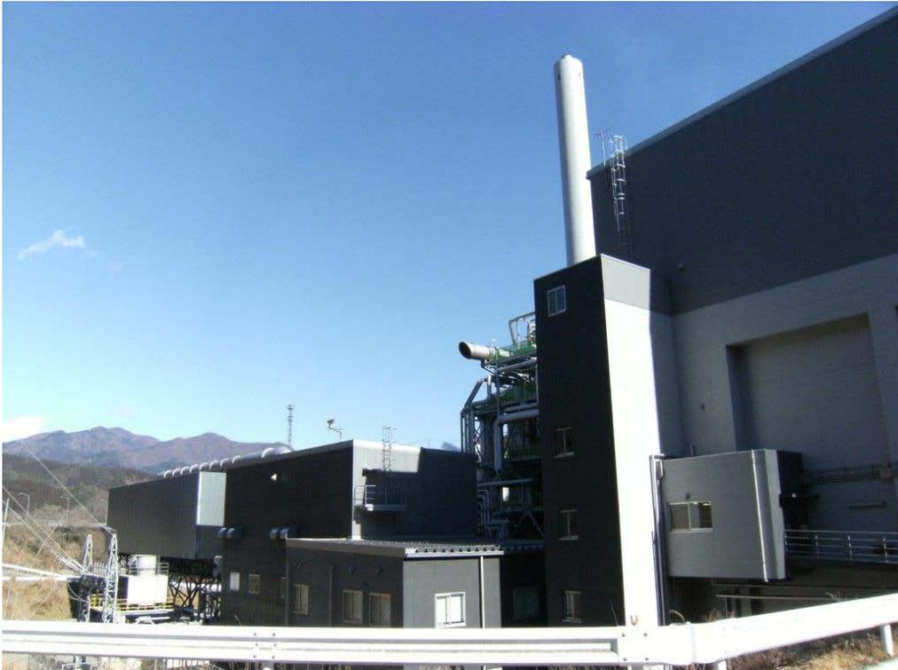
写真 10-3-1(1) サイレンサー（写真中心部の円筒部分）
