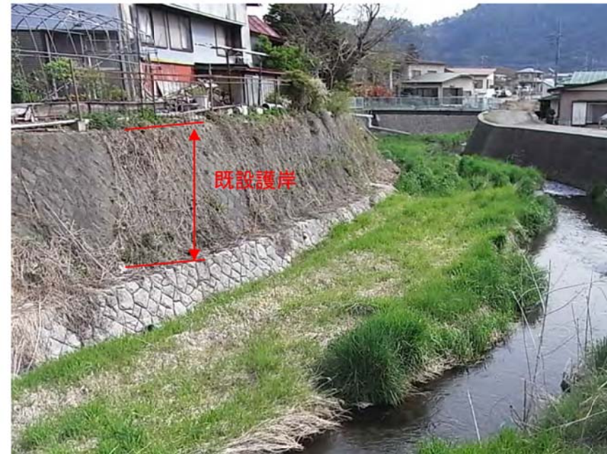
写真⑤既設護岸利用状況
